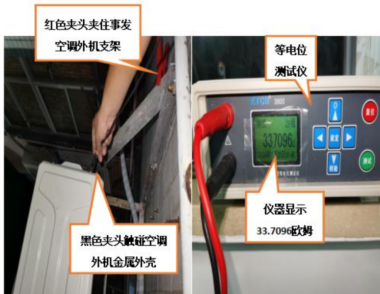
图 15 ①号空调外机金属外壳与支架导通情况勘查图
